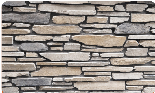
pose avec joints
